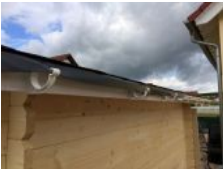
Für die Regenrinnenhalter mit Schnur ein Gefälle spannen, dann anbringen.
