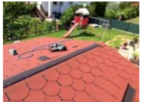
für gleichmäßiges Annageln der Firstschindeln evtl. eine Schnur spannen.
