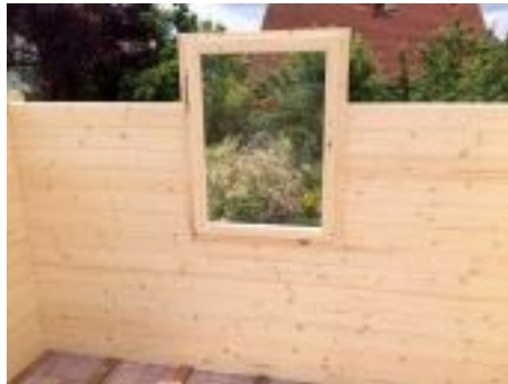
sofern vorhanden können Fenster später einfach von oben in die Aussparung geschoben/gesteckt werden
