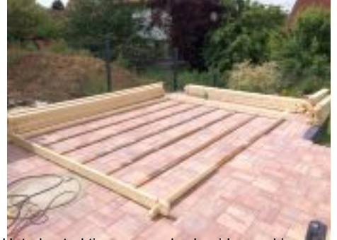
Unterkonstruktion passend schneiden und in ca. 40 – 50 cm Abstand vereinzelt andübeln 1. Bohlenreihe mit UK verschrauben.
