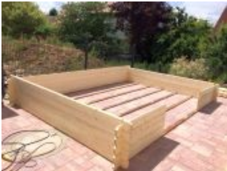
Folgende Bohlen werden nur gesteckt, nicht verschraubt. Manchmal muss mit Gummihammer nachgeholfen werden...
