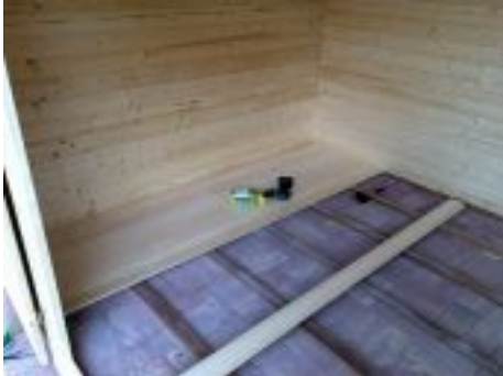
Sofern enthalten kann/muss am Ende noch der Boden (Fasebretter oder OSB-Platten) auf die UK geschraubt werden.
