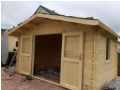
Gibel- und Ortgangsblenden verschrauben, falls vorhanden auch die Traufbretter (zwingend nötig bei Regenrinne), bitte Edelstahl-schrauben verwenden
