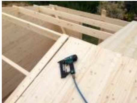
Dachbretter mit den Sparren verschrauben (oder mit Krallen anschießen).
