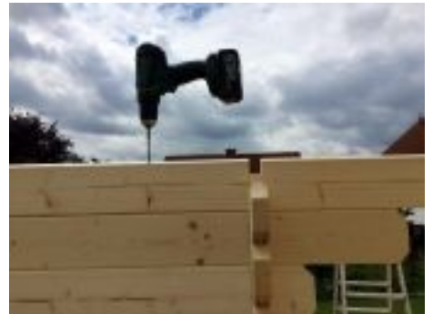
Letzte Bohle bitte wieder mit der darunter verschrauben (bitte Vorbohren !!!)
