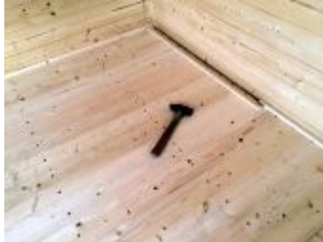
Zu den Wänden 1 cm Luft lassen, die Sockelleisten werden angenagelt.
