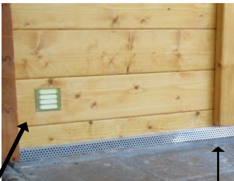
Zur Belüftung empfehlen wir Lüftungsgitter. Dazu an einer Wand unten, und gegenüber oben ein Loch in die Bohle Bohren, und die Lüftungsgitter anschrauben.
