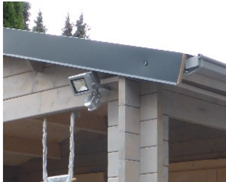
Für die Holzblenden an den Gibeln empfehlen wir passende Kantbleche.
