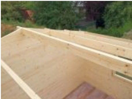
Auch die Giebel und die Sparren verschrauben.
