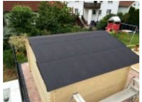
Dachpappe von unten nach oben über den First annageln.
