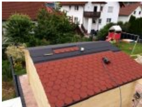
Beim Schindeln von unten beginnen, die Firstschindeln werden aus den Platten einzeln ausgeschnitten...
